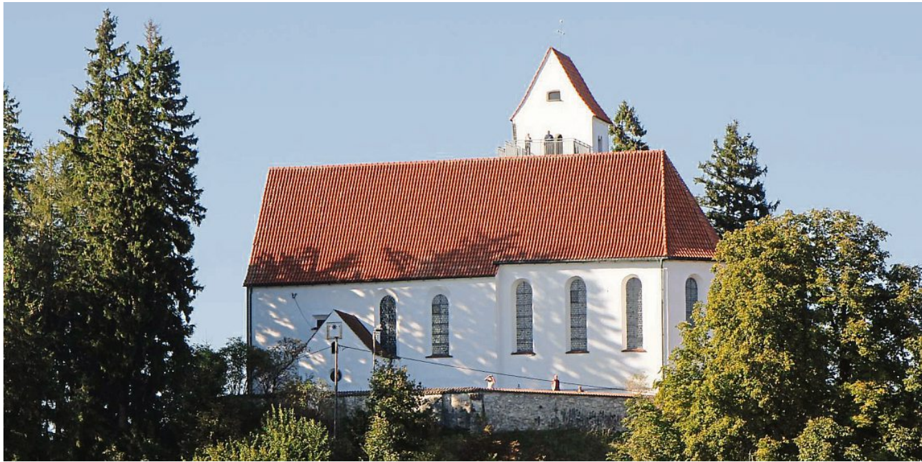
Die statische Sanierung des Dachs steht an, in ein paar Tagen wird die Auerbergkirche komplett eingerüstet.
